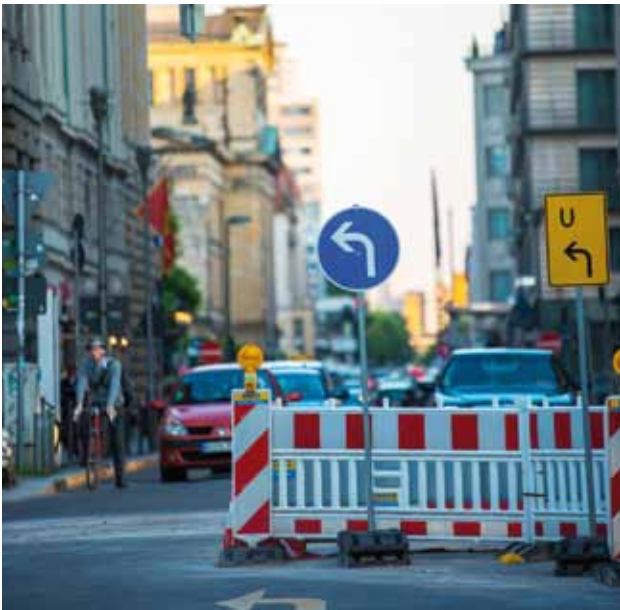
Baustellenbeschilderung in Berlin-Mitte | Quelle: shutterstock, Axel Lauer
