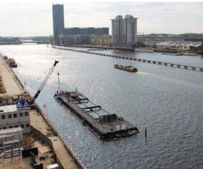
Bau der Pilotanlage Spree 2011 | Quelle: LURI.watersystems.GmbH©Steeg
