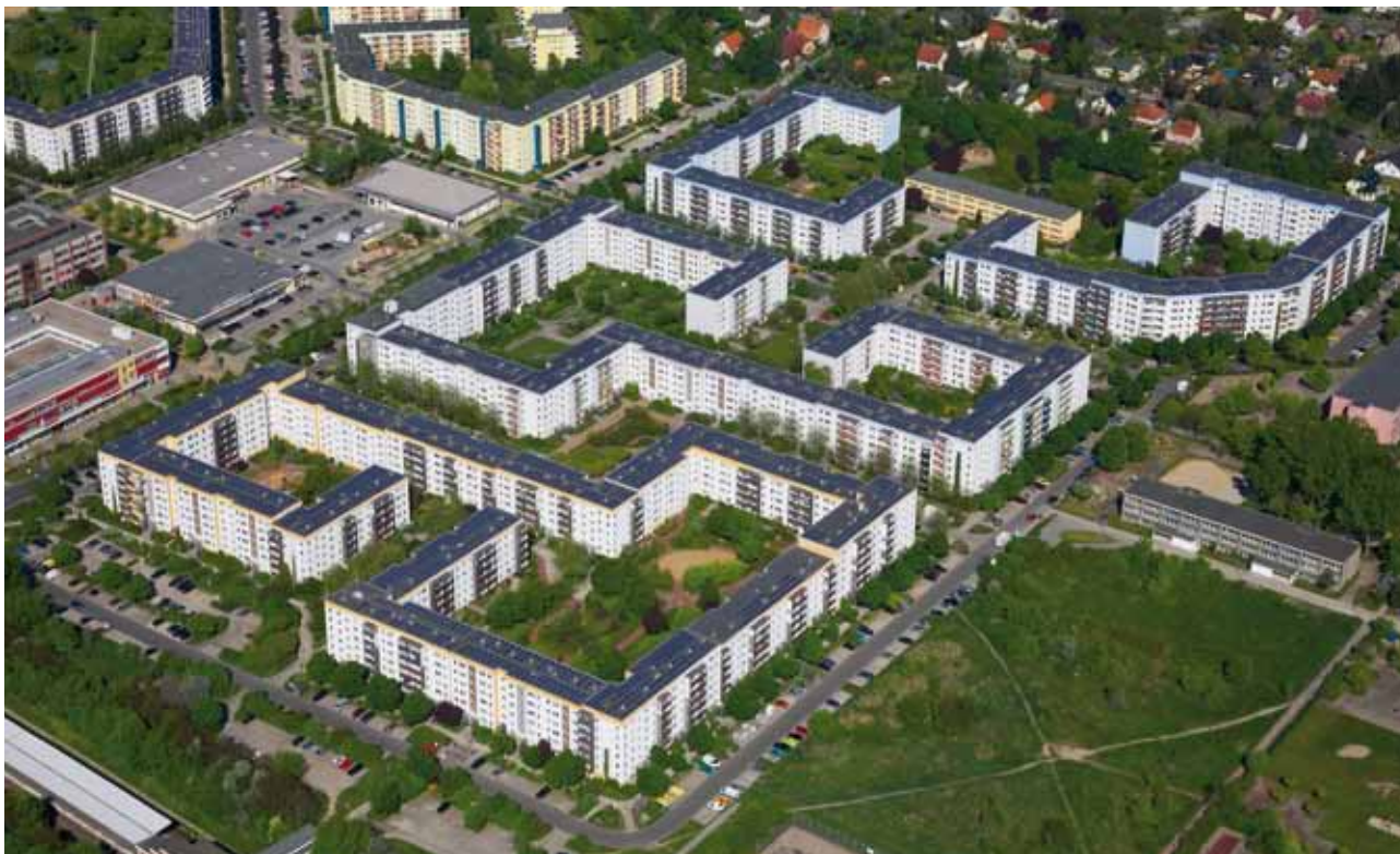
PV Anlage auf den Dächern des gelben Viertels in Hellersdorf | Quelle: Stadt und Land Wohnungsbaugesellschaft mbH
